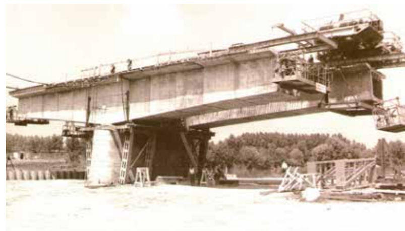
Kunszentmárton, első szabadon szerelt feszített vasbeton hidunk, 1975.
